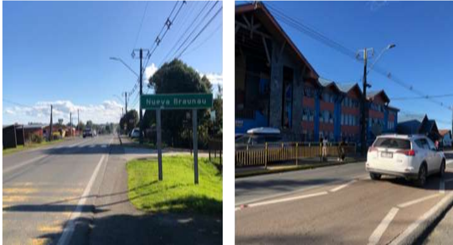
Figura 14. Acceso principal a Nueva Braunau - Ruta V - 500
