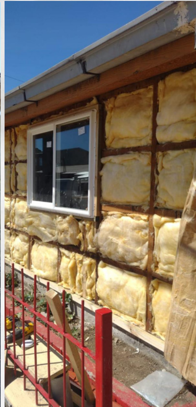
Solución aislación tabiquería perimetral
