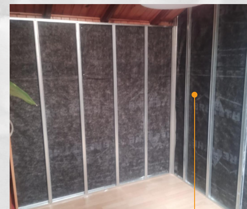
Solución aislación tabique adosado
