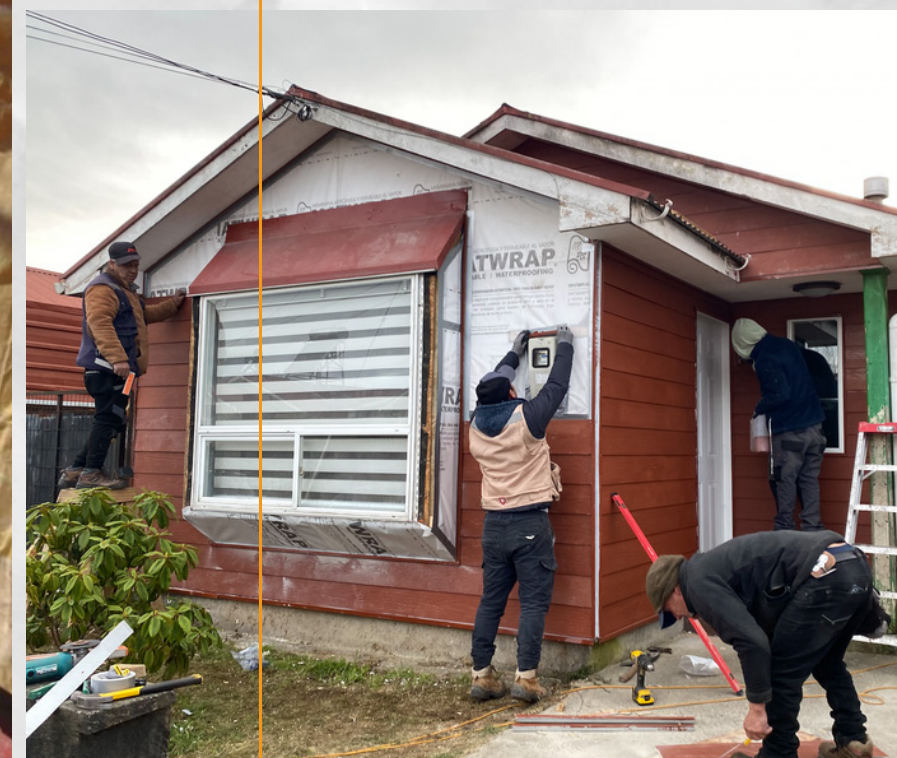
Solución aislación tabiquería perimetral
